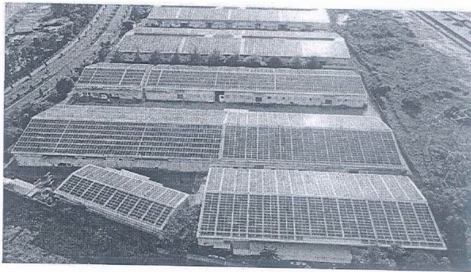
Hình ảnh hệ thống điện mặt trời mái nhà công ty đang sở hữu
